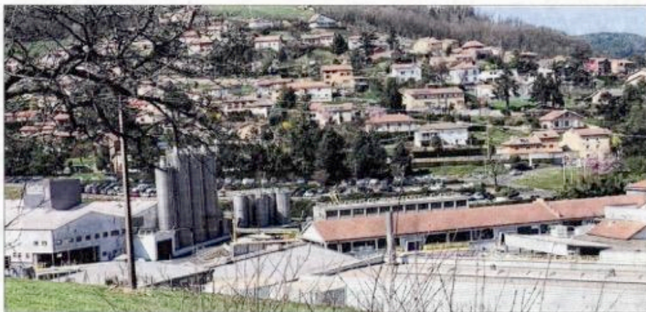
L'usine de production de Gerflor, à La Plaine, continue de se développer avec de nouveaux aménagements prévus. Photo Progrès/Yoann TERRASSE
